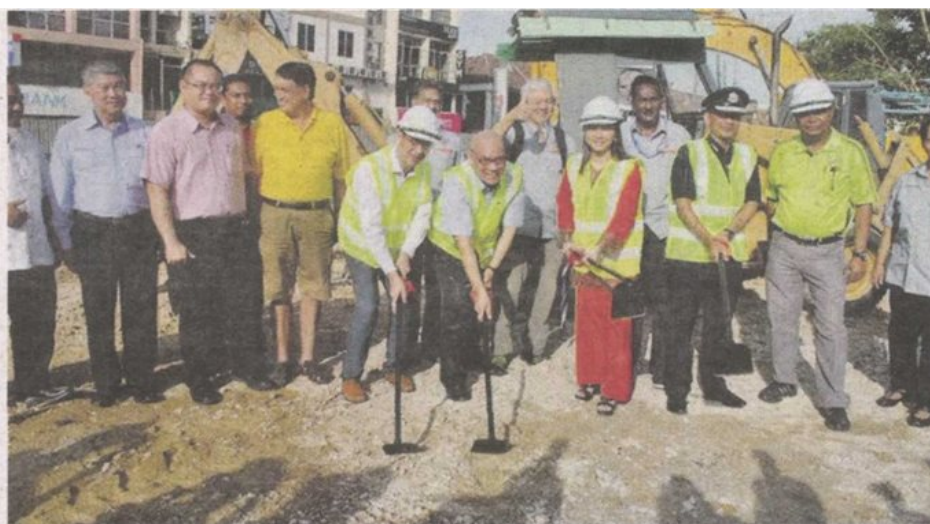
Nor Hisham (tengah), Hannah Yeoh (empat, kanan) dan penduduk ketika menyempurnakan Majlis Upacara Pecah Tanah Kompleks Tempat Letak Kereta Bertingkat di SS15.
