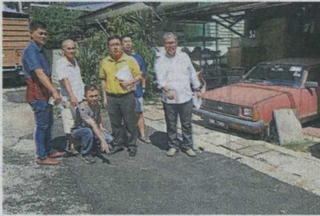
■无拉港区首阶段重铺道路工作已展开，黄田志(中)前往蕉赖十一哩新村巡视道路重铺情况。右为林志远，左是苏仁强。
